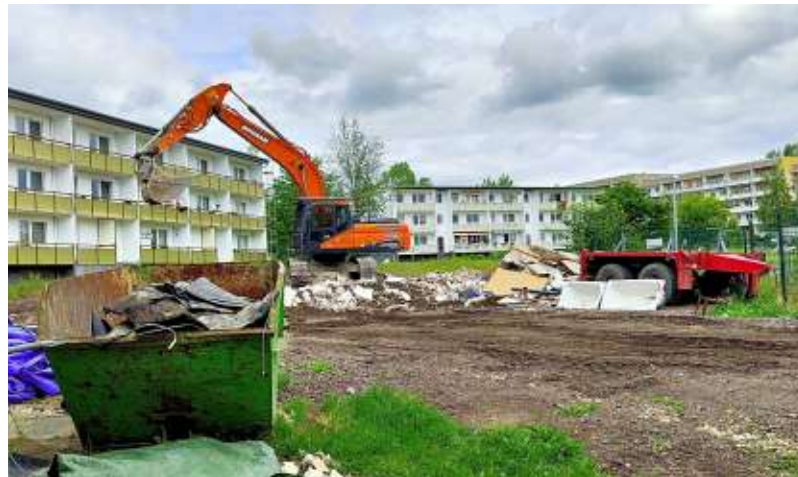
Die abgetragenen Betonplatten werden auf dem Hinterhof der Häuser zertrümmert und zerkleinert.
