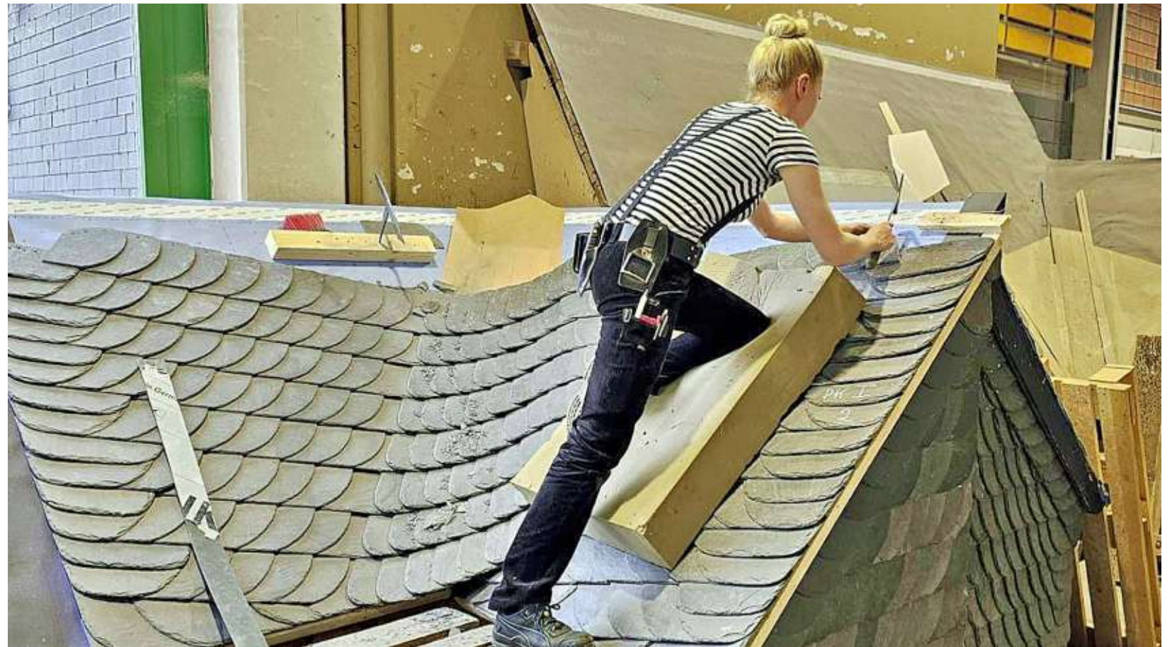
Dinah Metzner bei der Arbeit an ihrem Meisterstück – einer rechten, eingebundenen Schieferkehle auf etwa acht Quadratmetern Fläche. Jede Schieferplatte wird einzeln mit dem Hammer in Form gebracht. Die Arbeit musste in zwölf Stunden fertig sein. FOTO: D. METZNER
