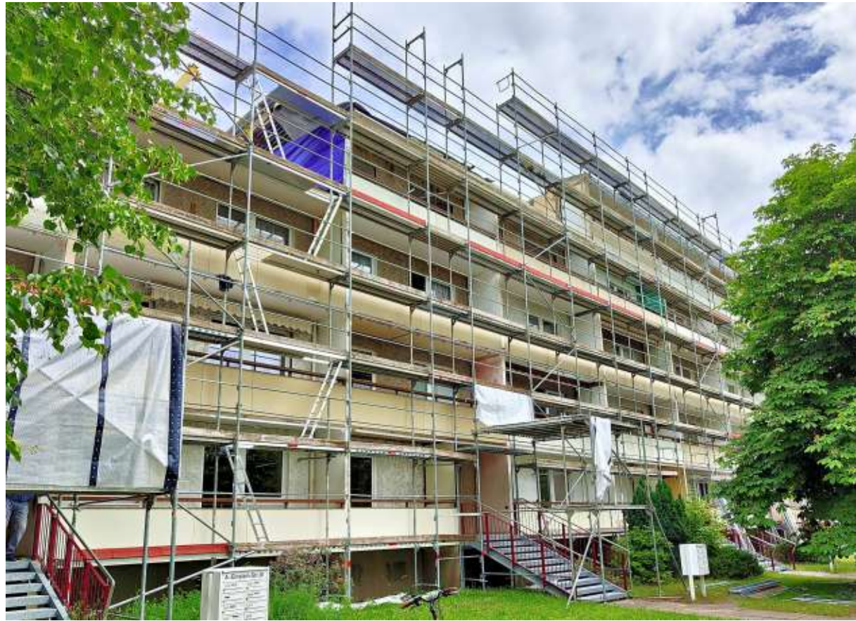
Einige Wohnblöcke in der Albert-Einstein-Straße in Stendal sind derzeit eine Dauerbaustelle.
